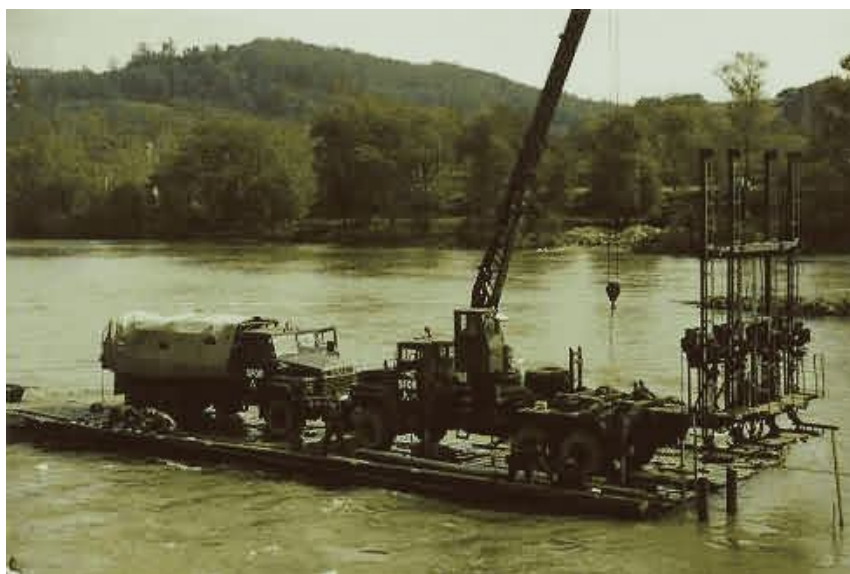
Cölöpözés PMP hadihíd kompról vízen 21
