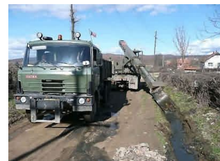
Vízvezető árok tisztítása 15
