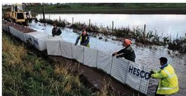
Az építőelemek telepítése árvízvédelmi töltésként 38
