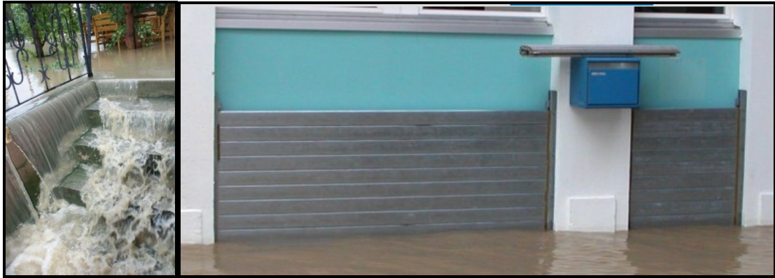
4. ábra Árvízvédelmi szerkezet 9
